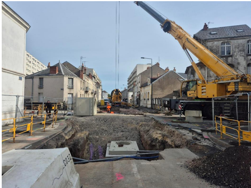
1-Mise en place cadre pluvial côté Nord du Boulevard
