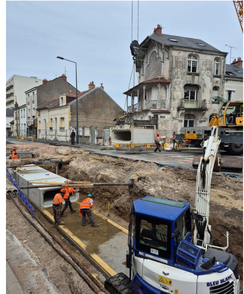
3-Mise en place cadre pluvial au centre du boulevard
