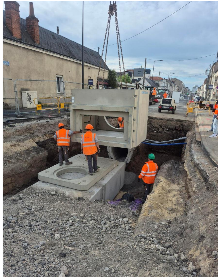
2- Mise en place cadre pluvial au Sud du Boulevard
