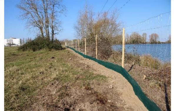
Exemple de clôture séparative entre emprises chantier (à gauche) et milieux connexes à préserver (à droite)
