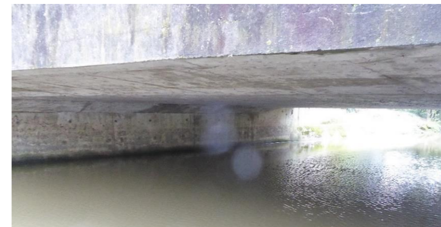
Figure 68 : photo du Pont Mozart (OA6) – Vue sous l'ouvrage
