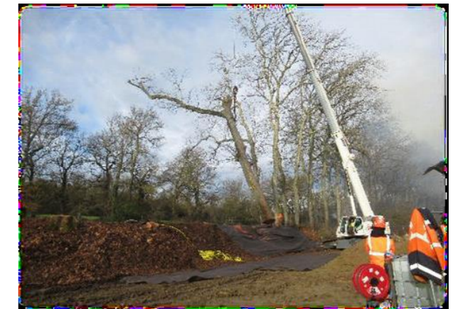
Grue avec nacelle
