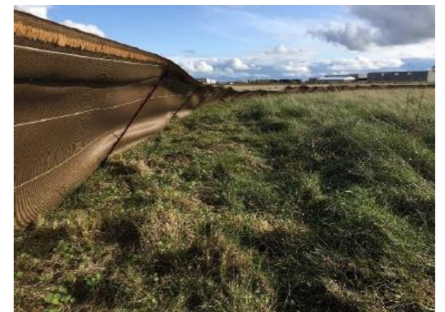
Exemples de filets de protection à sens unique de la petite faune terrestre mis en place au niveau d'un chantier
