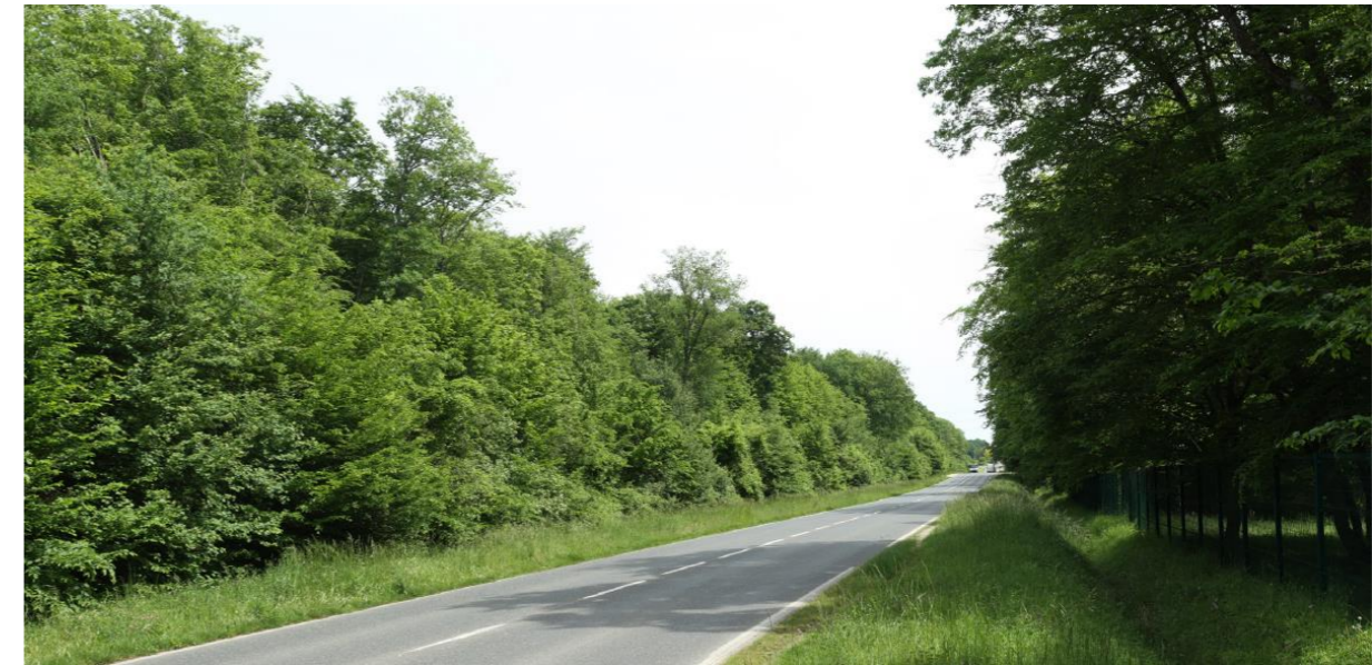
Figure 156 : photo en situation initiale sur route de Loches – Lycée agricole
