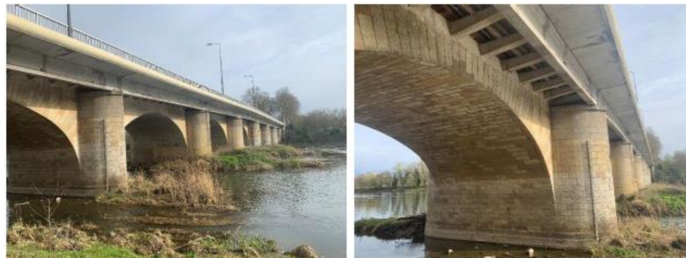
Figure 57 : photos de la structure de l'OA3
