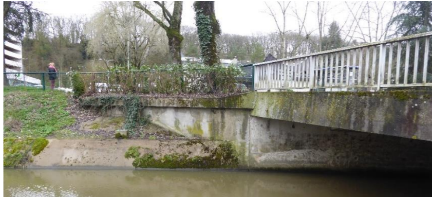
Figure 69 : photo du Pont Mozart (OA6) – Vue Sud-Est
