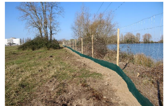
Exemples de clôture séparative entre emprises chantier (à gauche) et milieux connexes à préserver (à droite)
