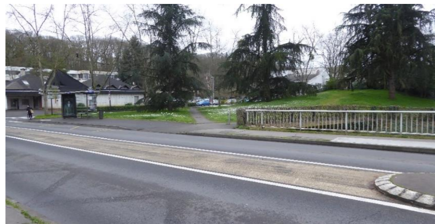
Figure 70 : photo du Pont Mozart (OA6) – Vue Sud-Ouest
