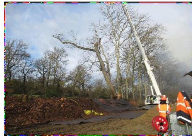
Grue avec nacelle
