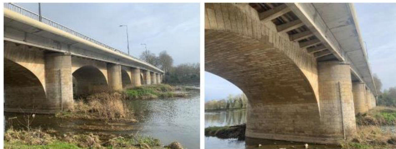
Figure 57 : photos de la structure de l'OA3
