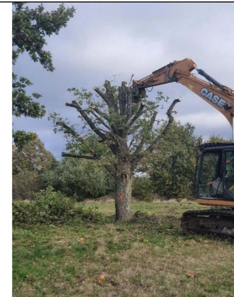
Maintien d'un arbre élagué avant abattage à l'aide d'une pelle mécanique pour déposer l'arbre au sol sans chute brutale
