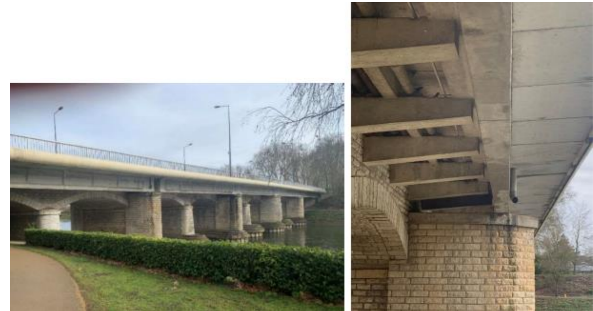
Figure 58 : photos de la structure de l'OA4
