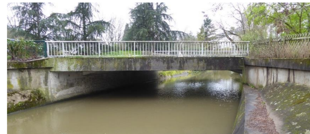
Figure 67 : photo du Pont Mozart (OA6) – Vue Est
