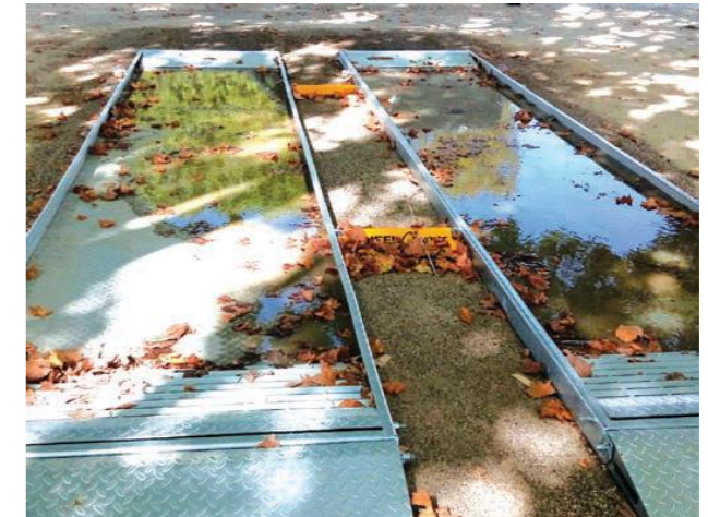
Exemple de pédiluve mobile en entrée de chantier (source : POUSSÉ CONSEIL)
