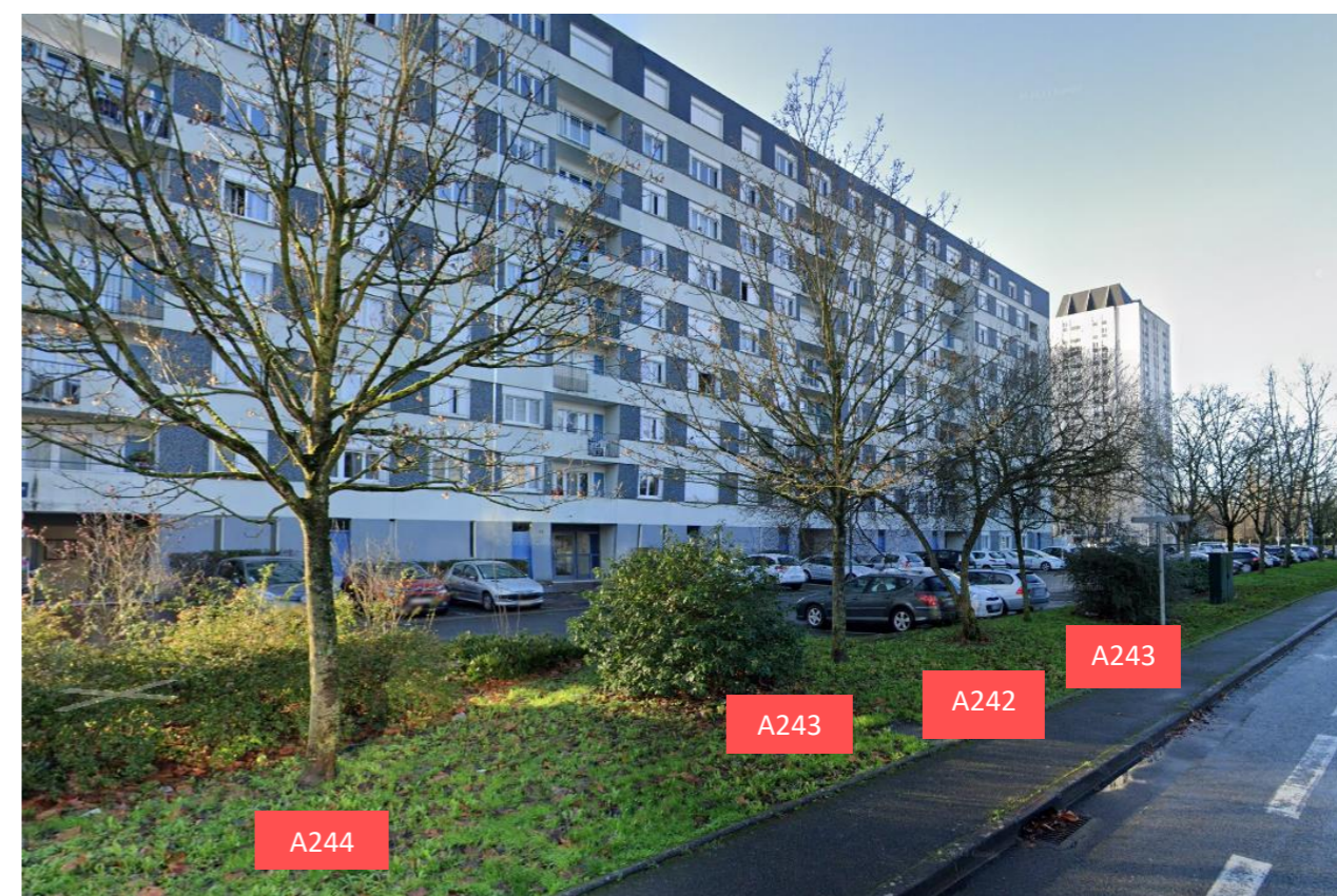
Figure 218 : photo des arbres des deux alignements impactés sur avenue Stendhal (côté Sud de la voirie)
