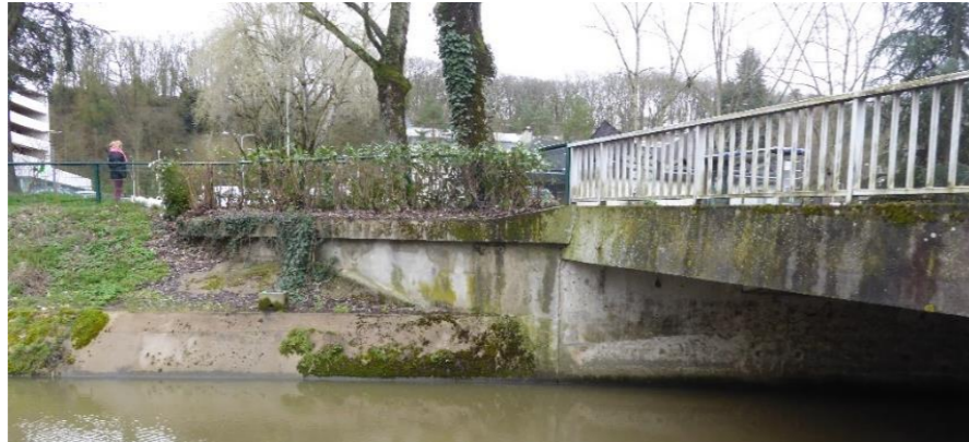
Figure 69 : photo du Pont Mozart (OA6) – Vue Sud-Est
