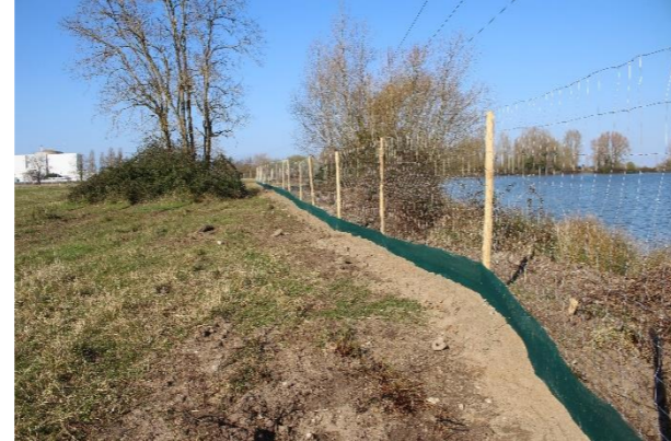
Exemples de clôture séparative entre emprises chantier (à gauche) et milieux connexes à préserver (à droite)
