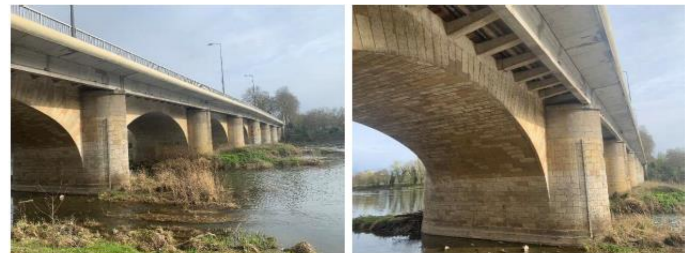
Figure 57 : photos de la structure de l'OA3
