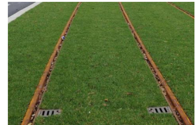
Figure 84 : boîte de drainage après revêtement
