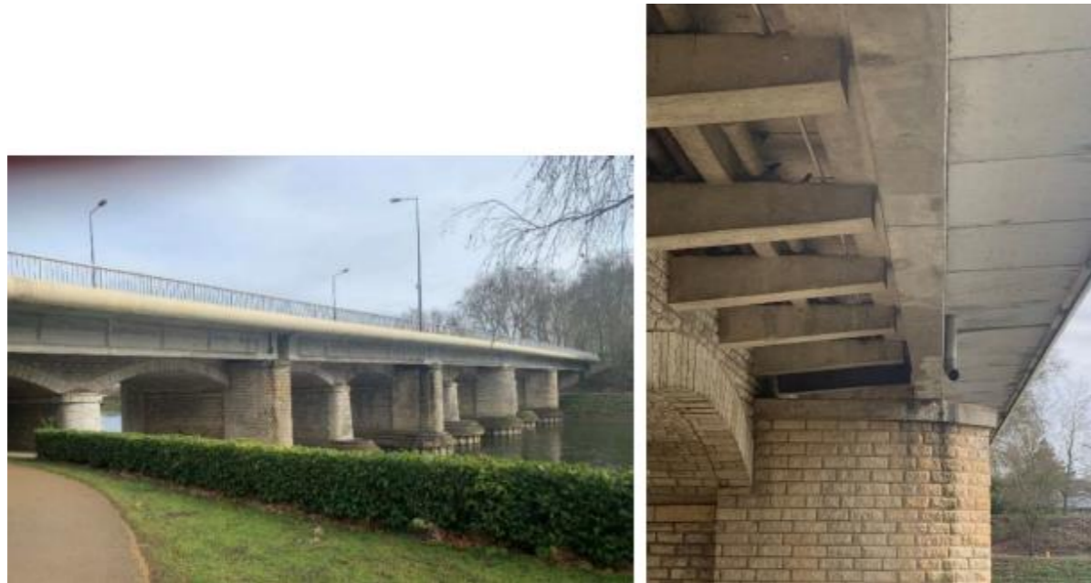
Figure 58 : photos de la structure de l'OA4
