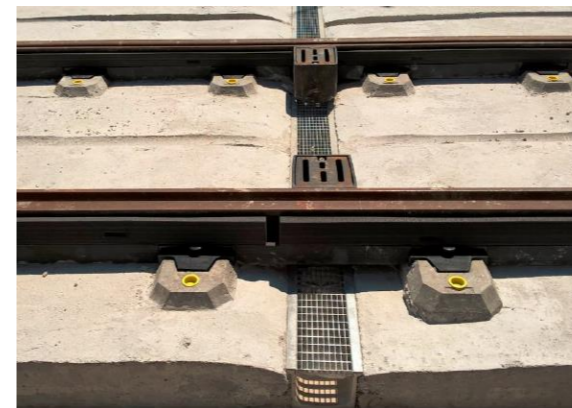
Figure 83 : boîte de drainage avec grille verrouillée, avant couche de revêtement
