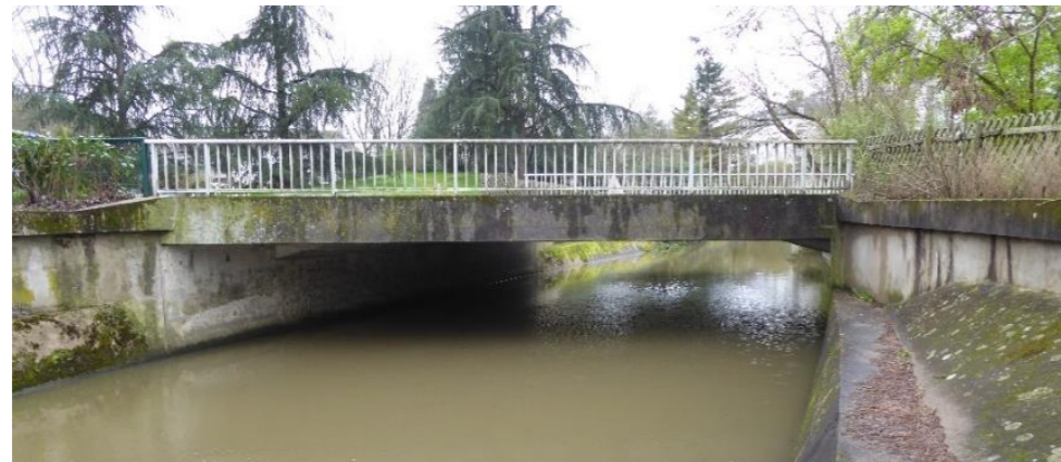
Figure 67 : photo du Pont Mozart (OA6) – Vue Est
