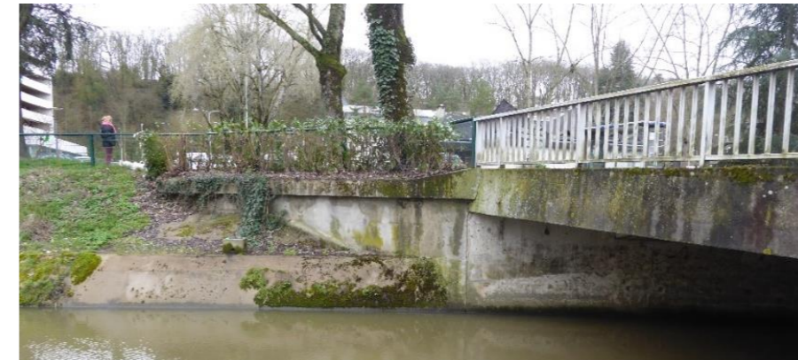
Figure 69 : photo du Pont Mozart (OA6) – Vue Sud-Est
