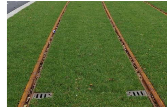
Figure 31 : boîte de drainage après revêtement
