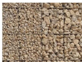
Gabion en pierres locales
