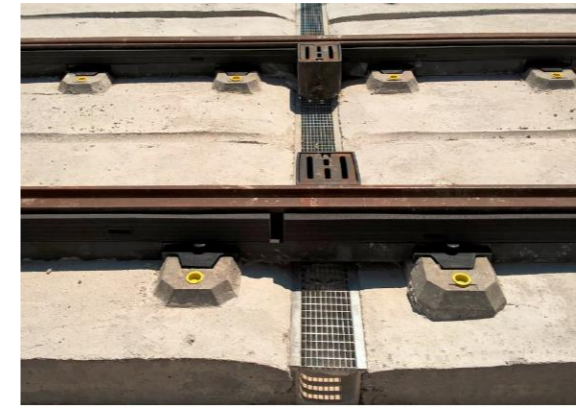
Figure 30 : boîte de drainage avec grille verrouillée, avant couche de revêtement
