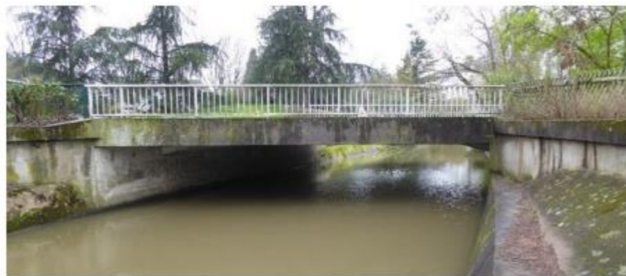
Figure 92 : vue de l'ouvrage existant – Côté Est
