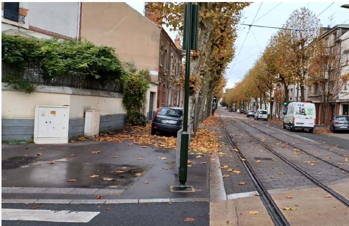
Préservation de tous les arbres, rue de la Gare à Orléans, positionnés à environ 1,5 m de la voie (Photo prise le 18 novembre 2024)
